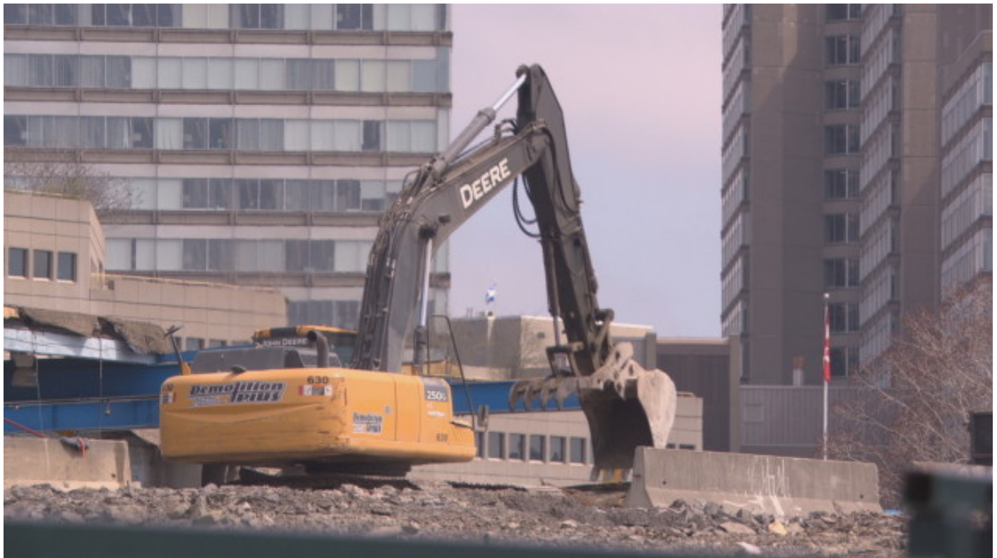
Travaux de décontamination du sol pour le projet immobilier Zibi Photo : Radio-Canada
