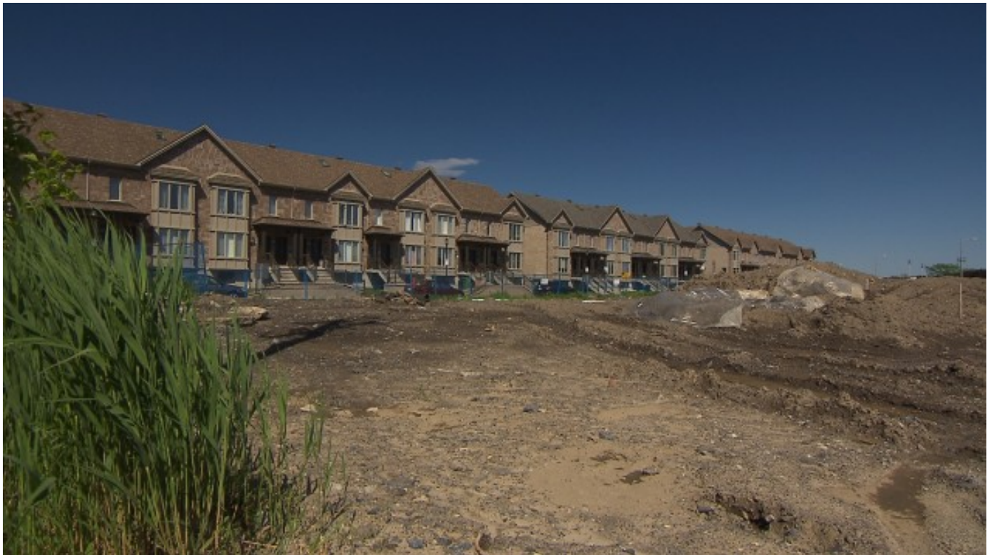
Décontamination du terrain VillaNova à Lachine Photo : Radio-Canada
